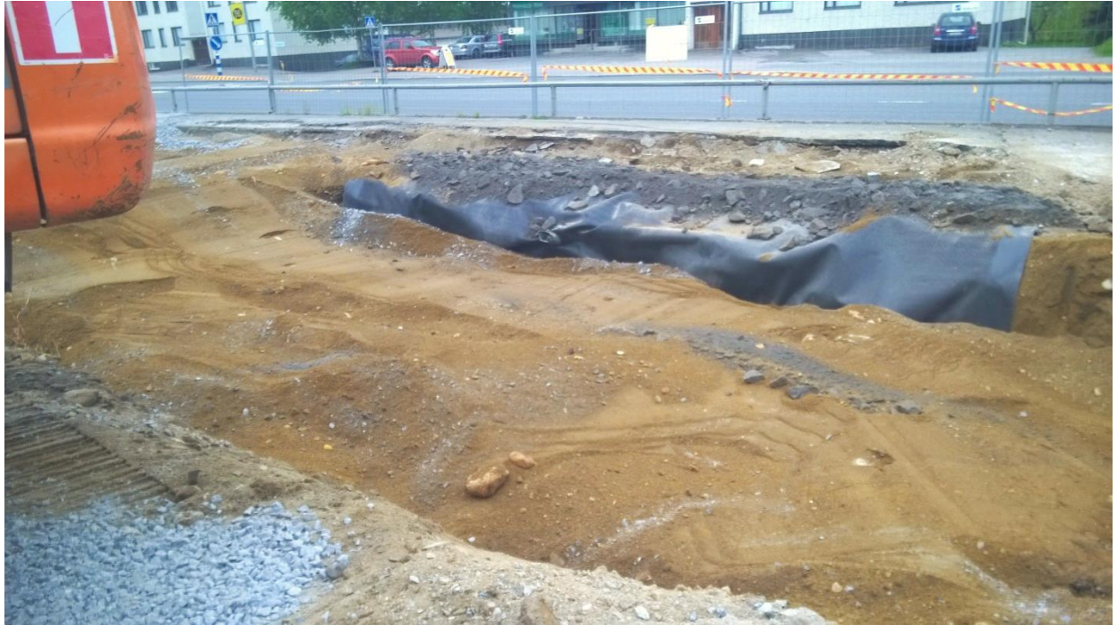
Kuva 9. Messukyläntien suuntaan kaivannon seinämään jäänyt pilaantunut maa-aines eristettiin HDPE-kalvolla täyttömaista.
