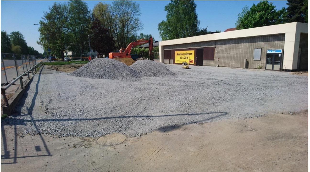
Kuva 5. Säiliökaivanto täytettynä, taustalla mittarikentän ja Messukylänkadun välissä sijaitseva pilaantuneen maa-aineksen kunnostuskaivanto.
