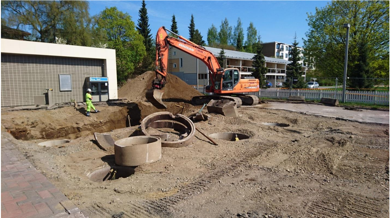
Kuva 1. Purku- ja kunnostustyöt aloitettiin maanalaisten säiliöiden poistamisella.
