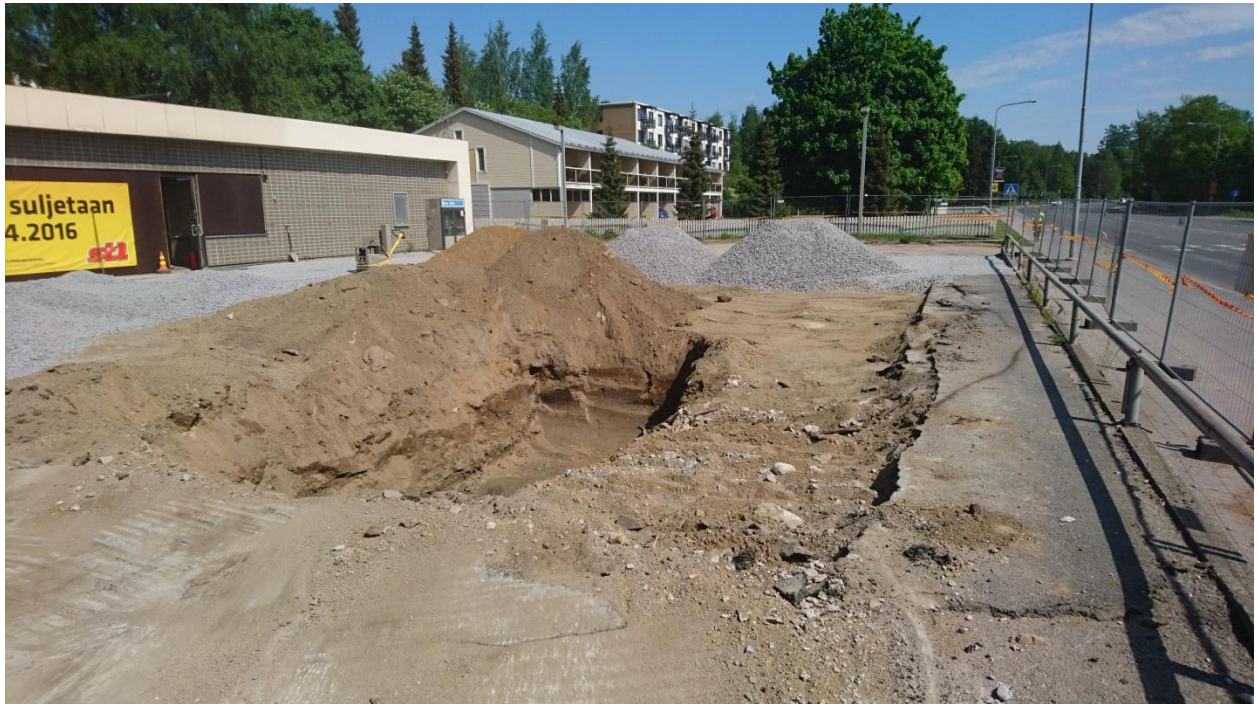
Kuva 7. Mittarikentällä todetun pima-alueen kaivut alkuvaiheessa.
