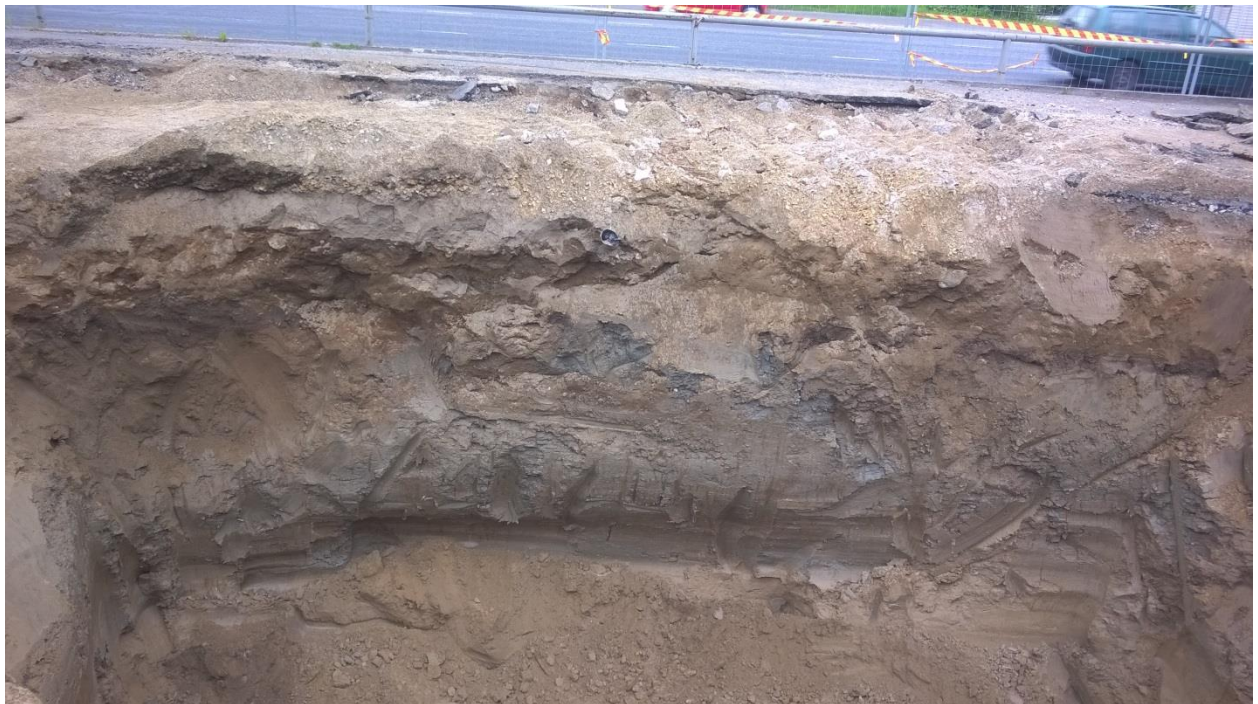
Kuva 8. Mittarikentän pima-kaivannon savinen seinämä Messukylänkadun suuntaan. Seinämään asennettiin HDPE-kalvo.
